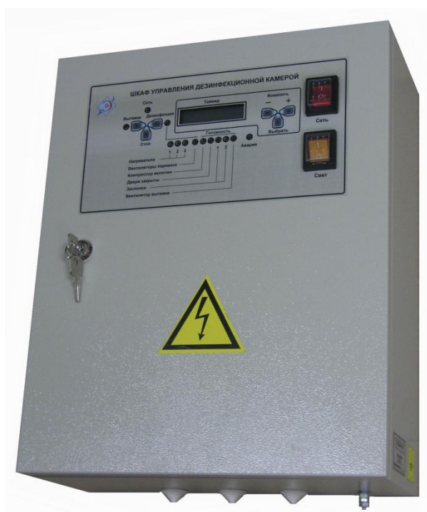
Рисунок 1.1 - Внешний вид шкафа управления
